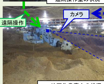
地下作業室内の状況
