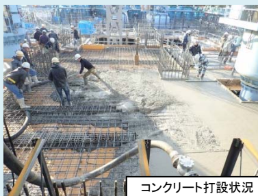
コンクリート打設状況
