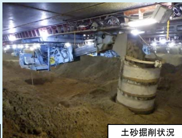
土砂掘削状況
