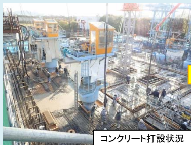
コンクリート打設状況
