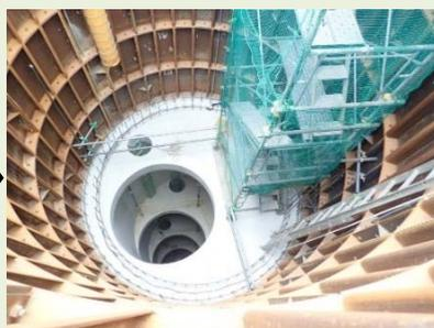
▲ 立坑内にコンクリートを打設し、ドロップシャフトを設置する開口部を設けています。
