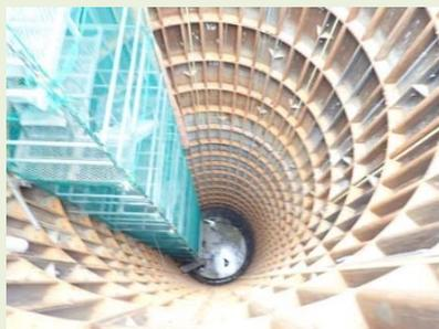
▲ マンホール工事前の立坑です。この立坑の中にマンホールを築造します。
