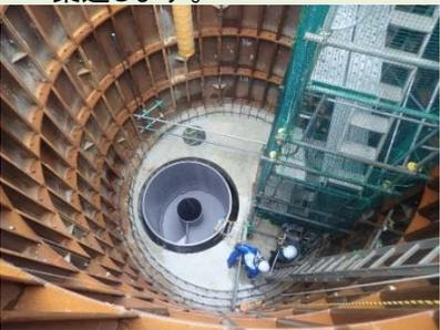
▲ 開口部を設けていた箇所にドロップシャフトを設置します。
