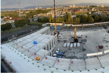
重さ9tのブロックを組立中
