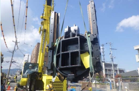
ゲート本体設置作業
