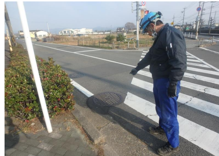
洛南浄化センター 幹線管渠調査訓練
