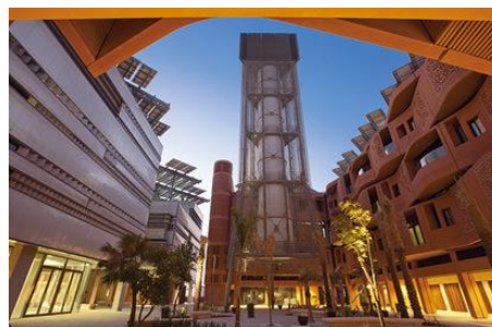
上空の風を冷気に変えて地面に吹き付ける仕組み(大和ハウス工業ホームページより引用)
