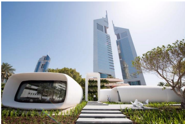
3Dプリンター建築 (SK本舗社ホームページより引用)
