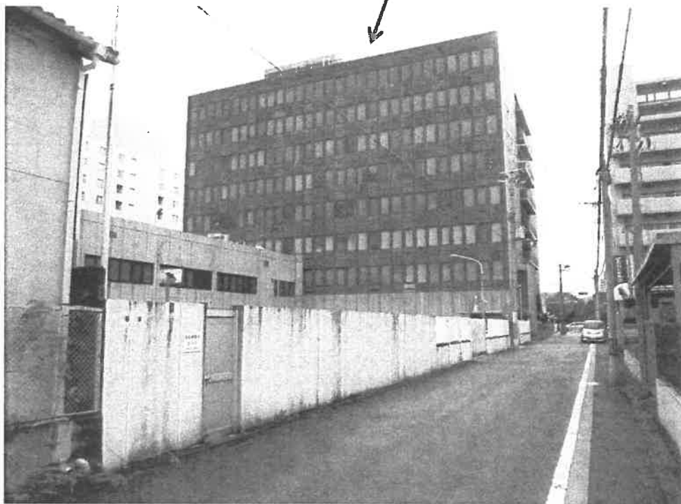
北東側より撮影
