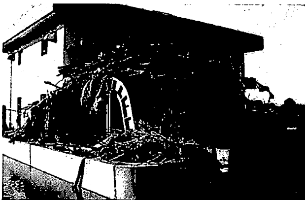
【津波で機能を喪失した排水機場】 (福島県)
