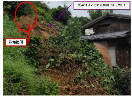
台風18号災害 [ がけ崩れ ] (宮津市長江)
