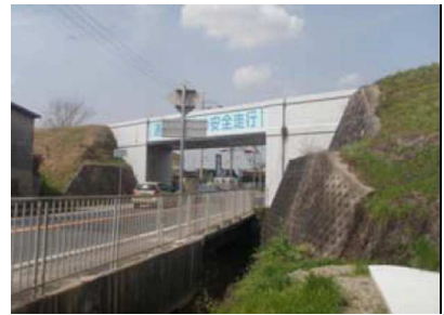
波川 ( 国道交差部 )
