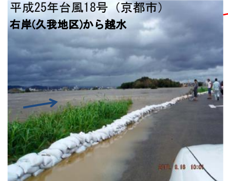
(直轄) 桂川 平成25年台風18号 (京都市)
