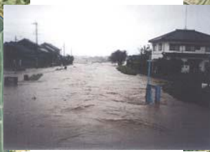
平成10年 浸水時
