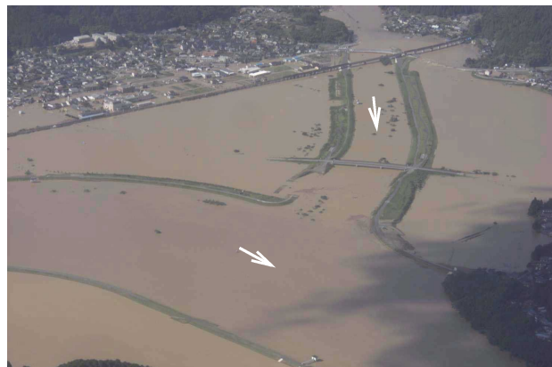
平成 25 年台風 18 号 由良川洪水状況（福知山市河守）
