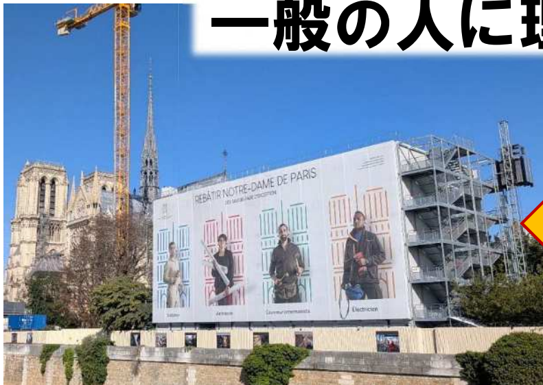
ノートルダム寺院の修復工事
