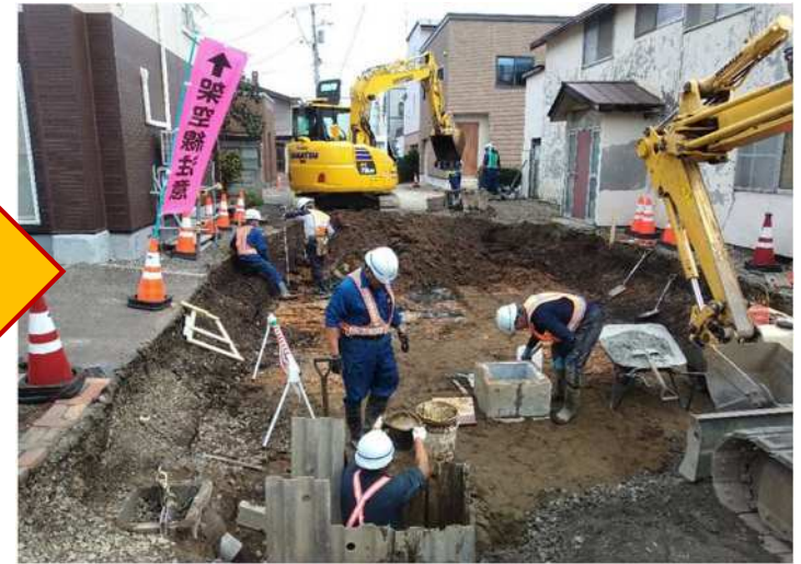
変わらない街中の小規模工事
