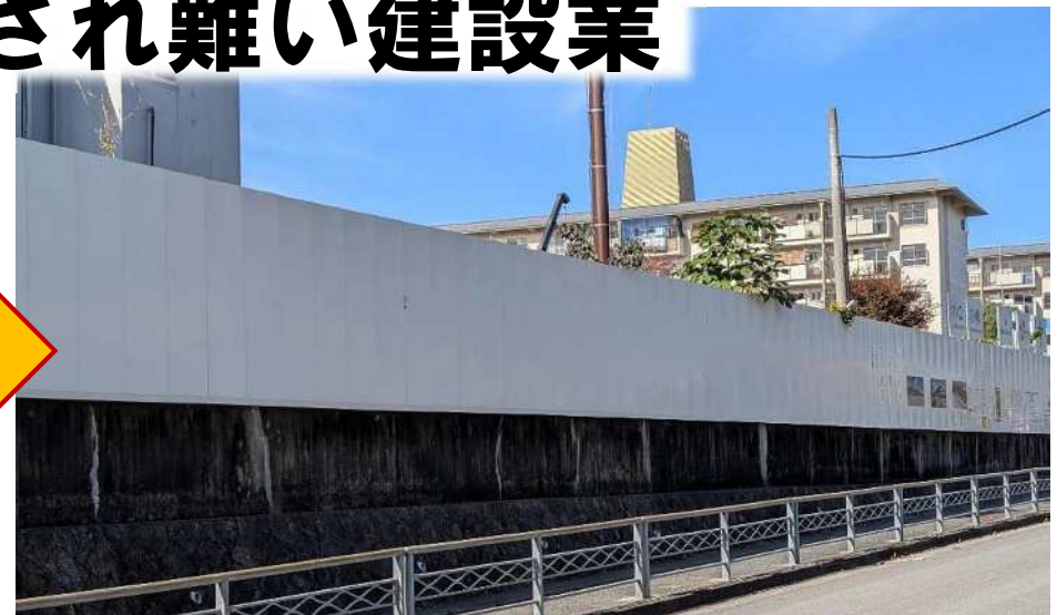
一般との接点を作らない工事現場
