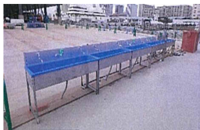
現場の手洗い場所の増設
