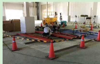
工事エリアの区画を設定して作業
