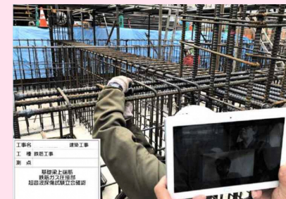
Webカメラを利用した遠隔検査
