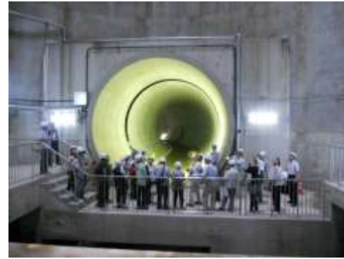
雨水北幹線第3号管渠
