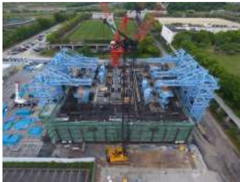
呑龍ポンプ場 (洛西浄化センター内)
