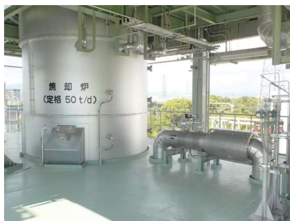
図 5.2 3号焼却炉（左：全景、右：焼却炉本体）
