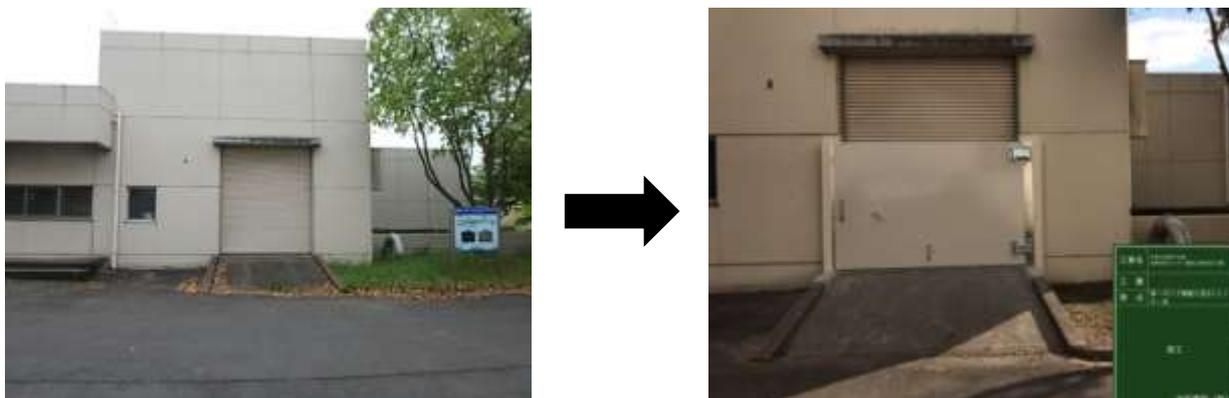
図 4.7 耐水化の整備例（洛南浄化センター第 1 ポンプ棟）
