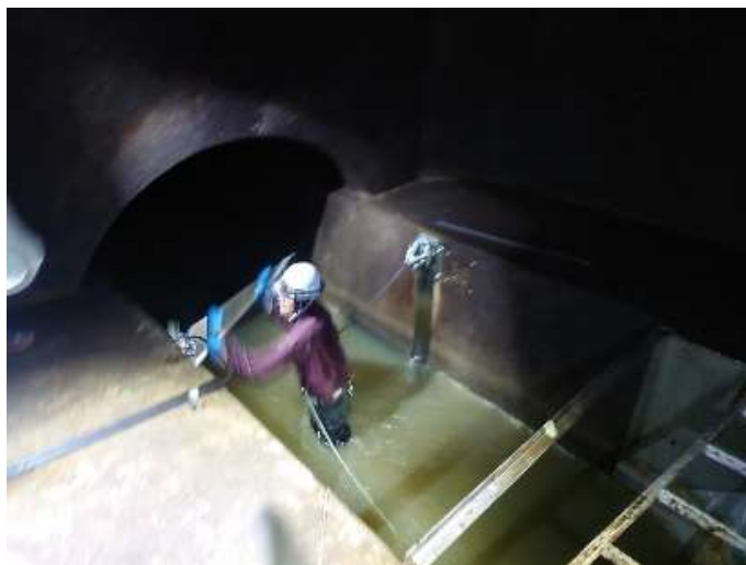
下水管渠内での点検・校正状況
