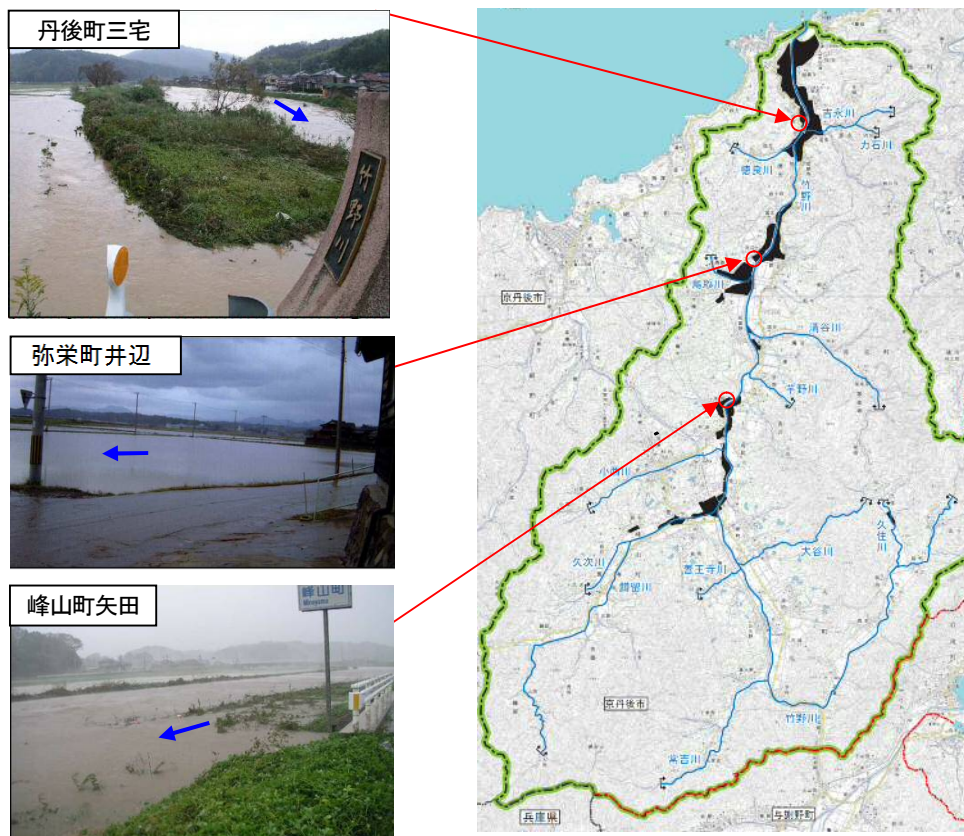
図9 浸水被害の状況(竹野川、平成16年10月洪水)
