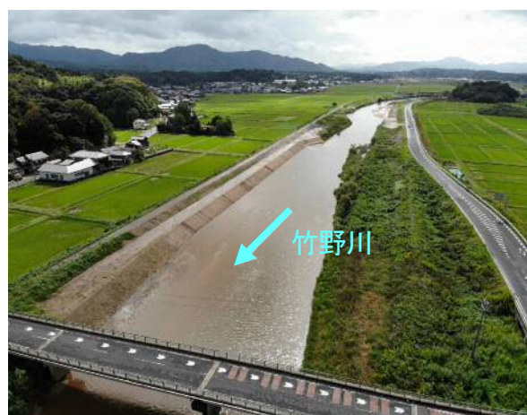
図 17 竹野川の改修後 (国久橋上流 6.600K 付近)
