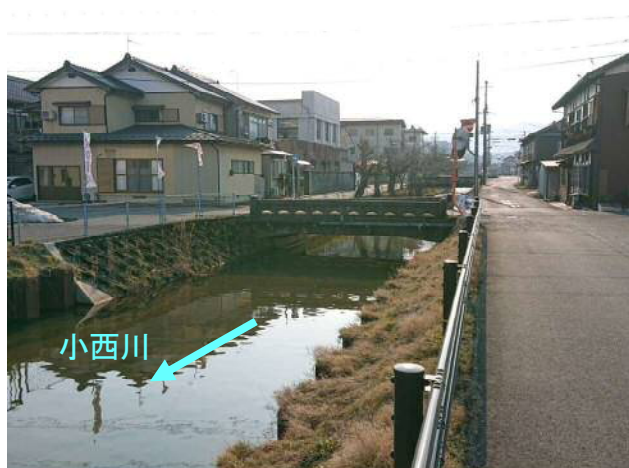
図 22 小西川整備区間②の改修前（樋田橋）
