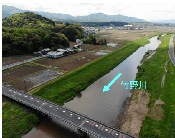
図 16 竹野川の改修前 (国久橋上流 6.600K 付近)
