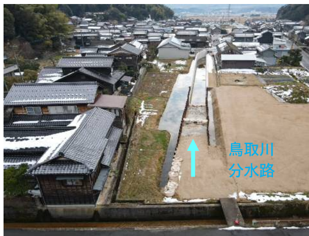
図 25 鳥取川の改修前（分水路部分）
