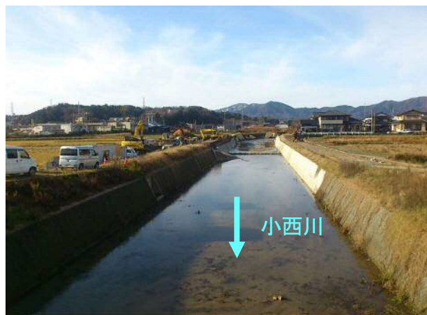
図 21 小西川整備区間①の改修後 (三町田橋から上流)
