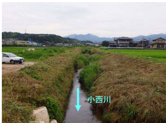
図 20 小西川整備区間①の改修前 (三町田橋から上流)
