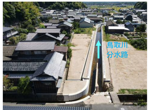
図 26 鳥取川の改修後（分水路部分）
