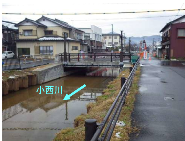
図 23 小西川整備区間②の改修後（樋田橋）
