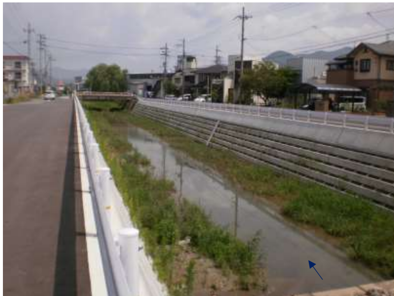
図 7.3 環境配慮型護岸の採用（弘法川）
