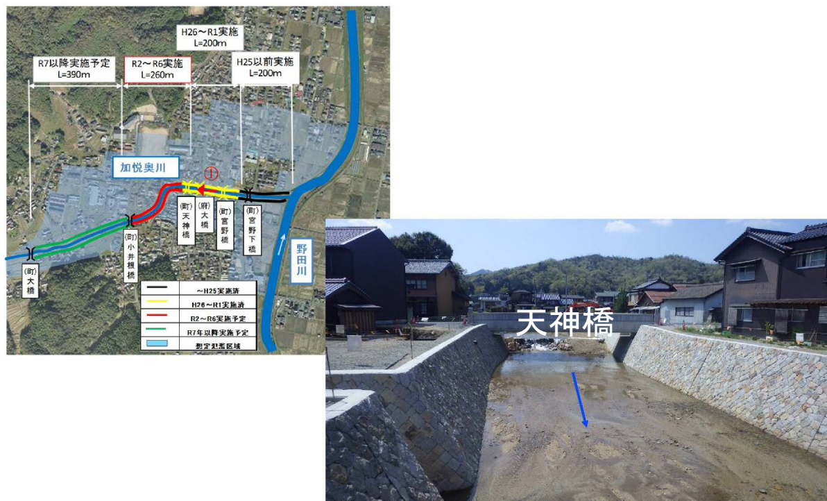
図 10 加悦奥川の改修状況
