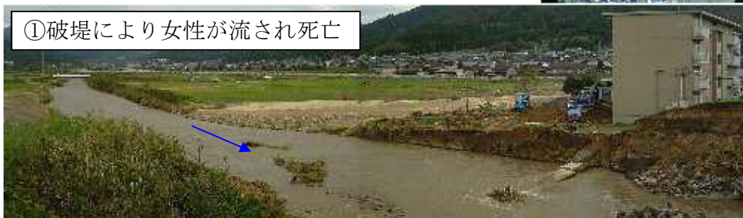
図 6 浸水被害状況 (平成 16 年 10 月台風 23 号)
