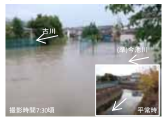
②今池川合流部の浸水状況
