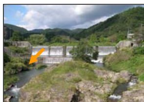
ひいらぎのえんてい 椋野堰堤付近
