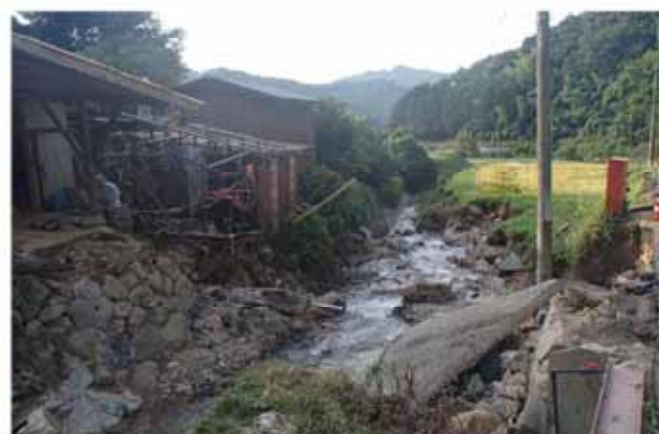
二級河川狩場川被災状況（宮津市新宮地区）
