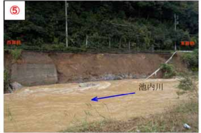
まいづるしべっしょ いけうちきょうだ 【場 所】 舞鶴市別所 (主) 池辺京田線 【被災状況】 路肩決壊、河岸浸食 延長 50m 【復旧内容】 大型ブロック積工
