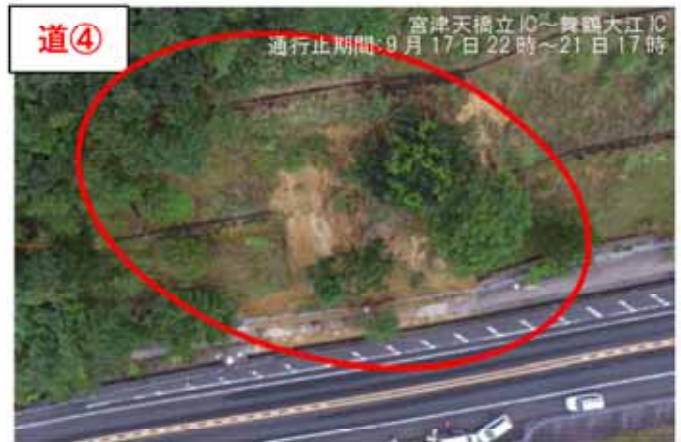
道④ 【場 所】 みやづし 宮津市 きょうとじゅうかんじどうしゃどう 京都縦貫自動車道 (国道 478 号) 【被災状況】法面崩壊 延長 35m (2 箇所 2 工区) 【復旧内容】吹付法枠
