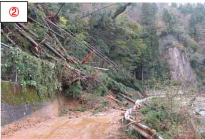
② 【場所】なんたんしみやまちょうしらいし 南丹市美山町白石 (主) きょうとひろがわらみやま 京都広河原美山線 【被災状況】法面崩壊 延長 120m 【復旧内容】吹付法枠
