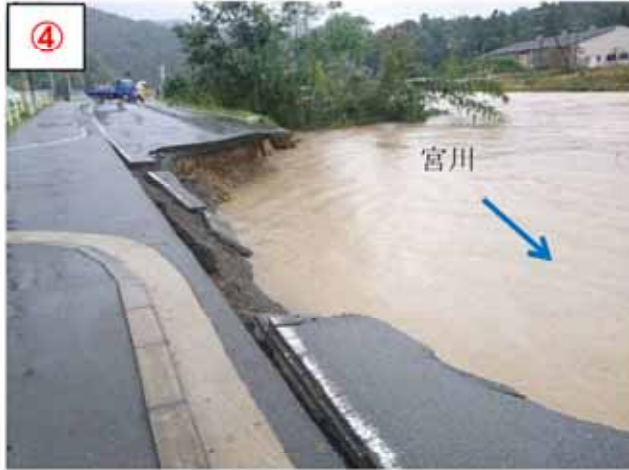
ふくちやましおおえちようせき おやべおおえみやづ 【場 所】 福知山市大江町関 (主) 綾部大江宮津線 【被災状況】 河岸浸食 延長 40m 【復旧内容】 大型ブロック工
