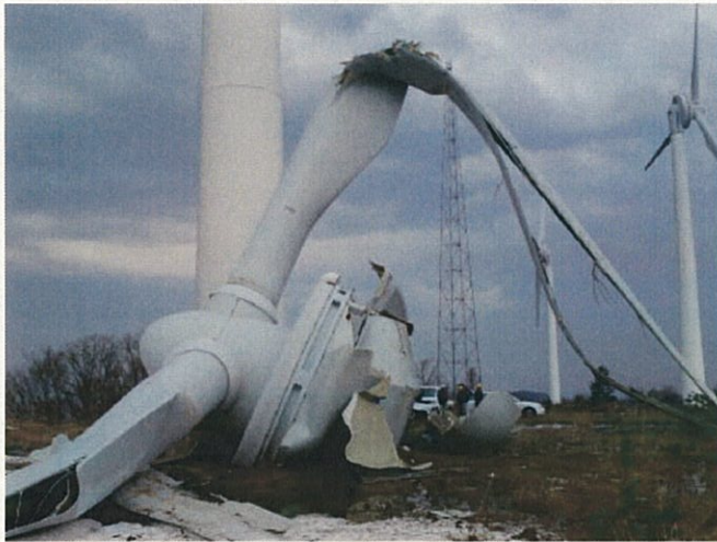
写真1 発電機・ナセル・ブレードの落下状況
