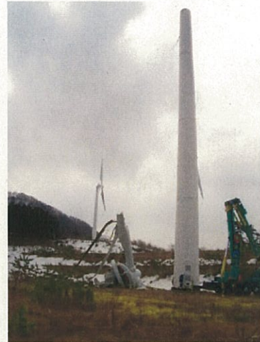
写真1 発電機・ナセル・ブレードの落下状況
