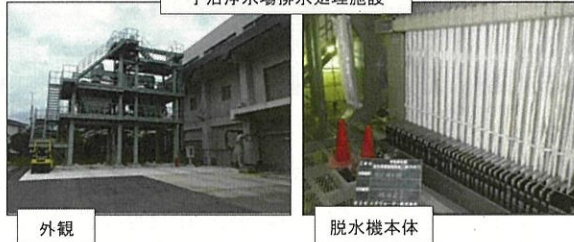
宇治浄水場排水処理施設
