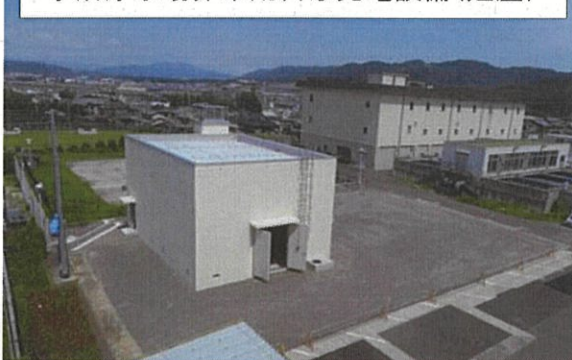
宇治浄水場非常用自家発電設備(建屋)
