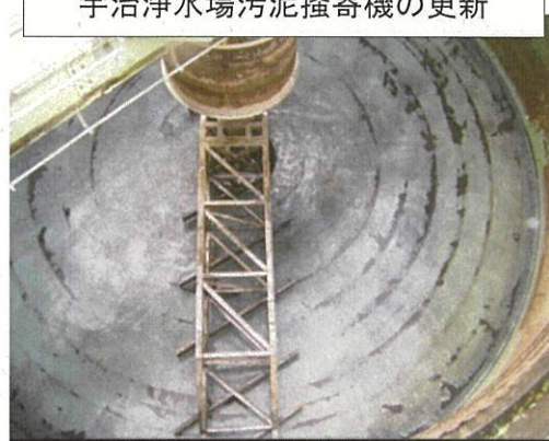
宇治浄水場汚泥掻寄機の更新
