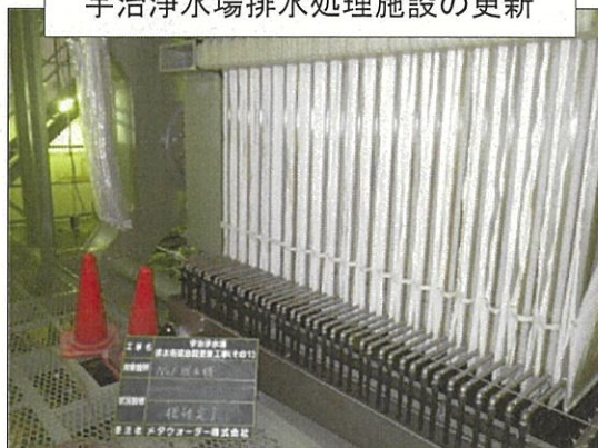
宇治浄水場排水処理施設の更新
