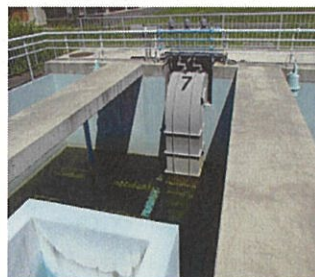
木津浄水場ろ過池改造 (クリプトスポリジウム等対策)
