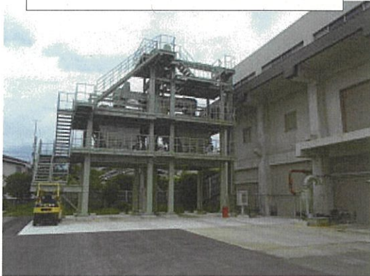
宇治浄水場排水処理施設(外観)
