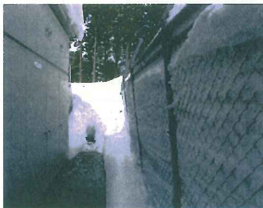
開閉所周辺積雪状況
