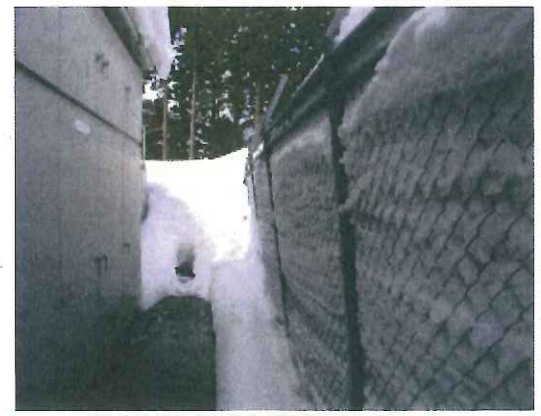
開閉所周辺積雪状況
