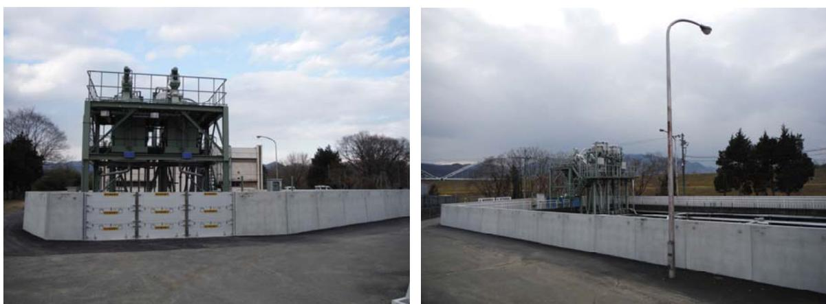
図 6-3 福知山市段畑ポンプ場 耐水対策例（止水板、止水壁設置）
