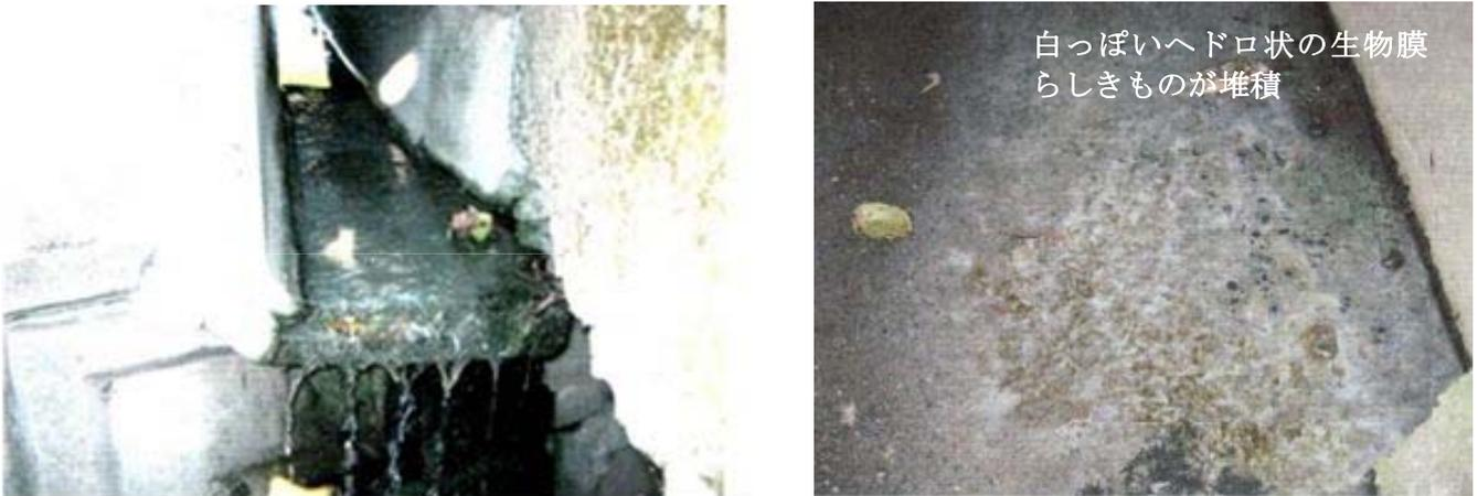
図 3-16 未処理の生活雑排水による水路の汚濁状況
