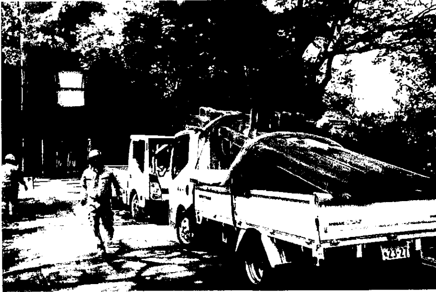
奥院勾欄部材の搬出作業
