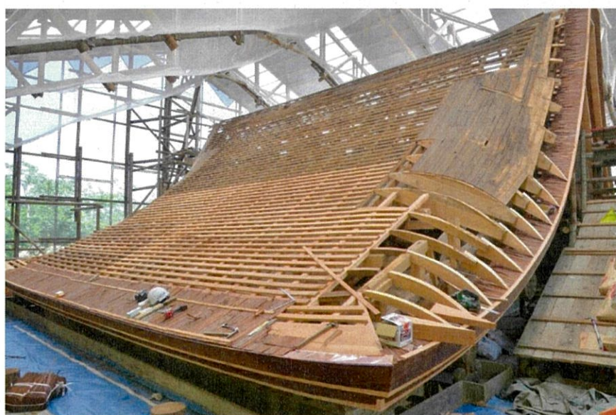
上目皮施工中
