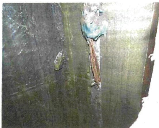
② ブレード内の断線の状況
