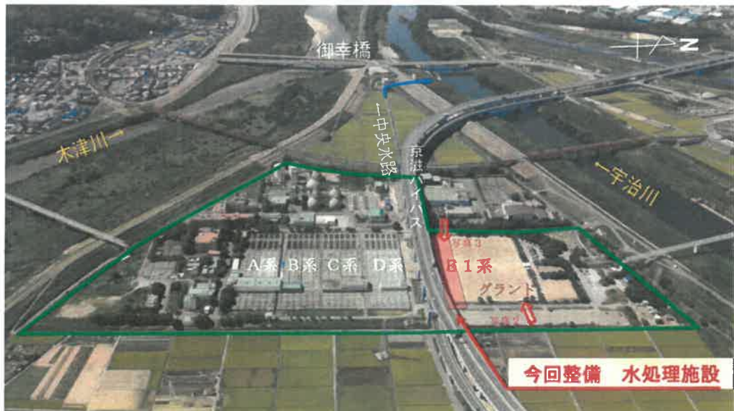
[写真1 洛南浄化センター全景 E1系水処理施設土木]
