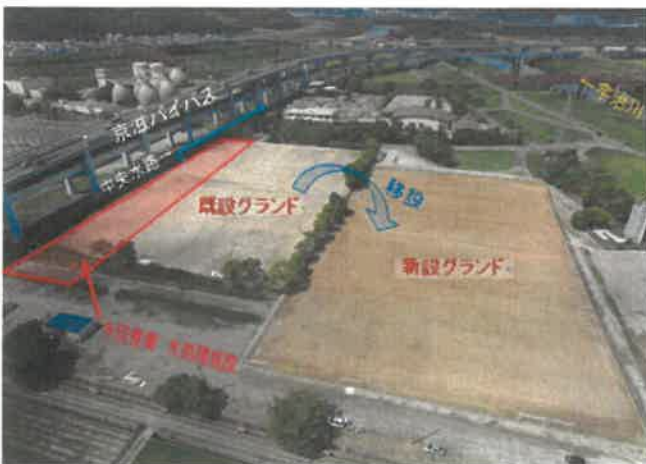
[写真2 (工事着手前)]
