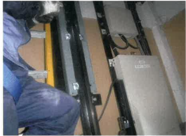
(3) 地震対策（レールバックング材） 取付後
