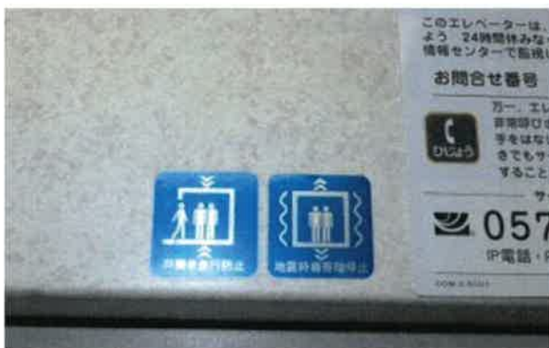
(4) 戸開走行保護装置設置済みマーク 地震時管制運転装置設置済みマーク
