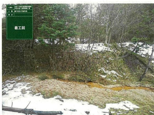
下流側 【着工前】
