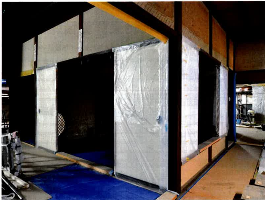
工事完了の状況
