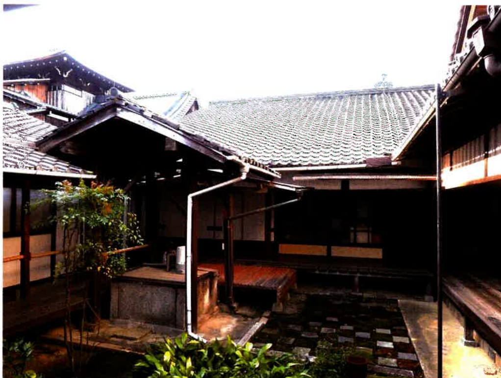
着工前の状況
