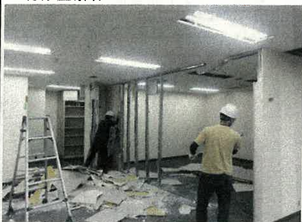
○ 作業中 ・ 既存壁解体
