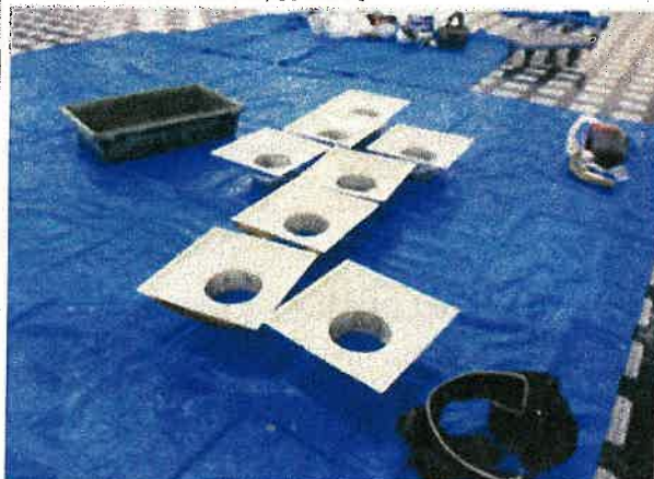
・ 空調機部品分解洗浄
