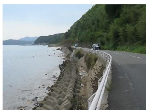
【写真-1 現況道路】
