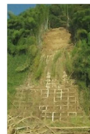
【写真-5 山側崩壊 (H25. 9. 15 台風)】
