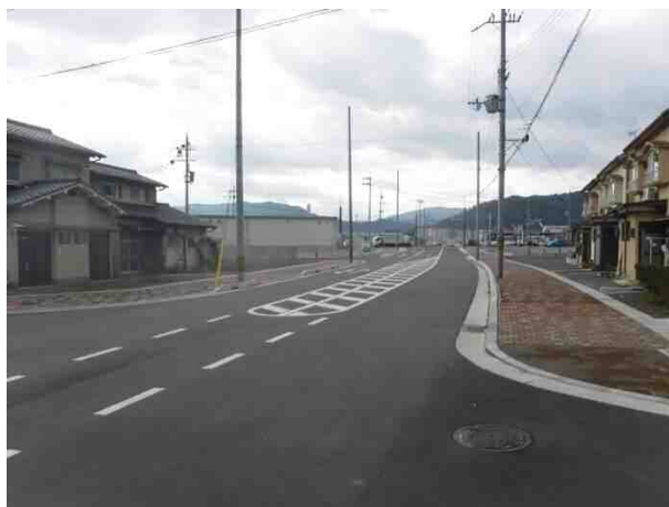
【写真-A 起点側整備中區間】
