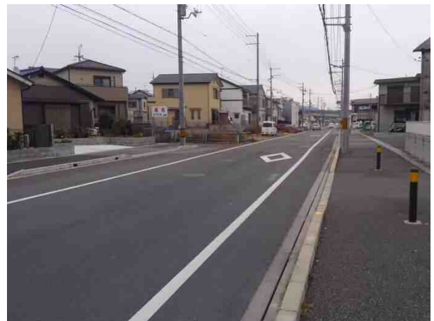
【写真-B 終点側事業中區間】
