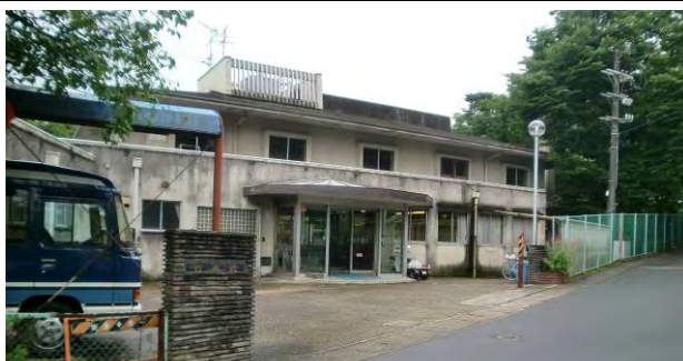
写真－5 長岡京市立老人福祉センター「竹寿苑」 ちくじゅえん
