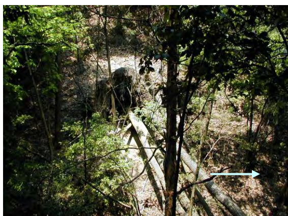
【写真－3 倒木、山腹崩壊：支川溪流】
