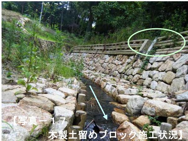
【木製土留めブロックの 空隙から植生が回復】
