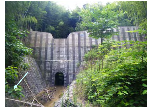
【写真一11 支川堰堤 施工箇所（大暗渠型）】
