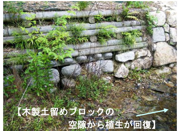
【写真-17】 木製土留めブロック施工状況】
