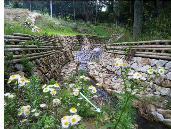
【写真一10 溪流保全工施工箇所】
