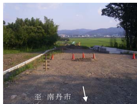
写真④ 工事の進捗状況
