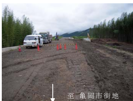
写真③ 工事の進捗状況
