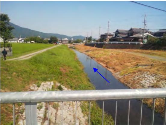
国主ヶ森橋より下流を望む。1:2.0で護岸が整備されており法面には植生が繁茂している
