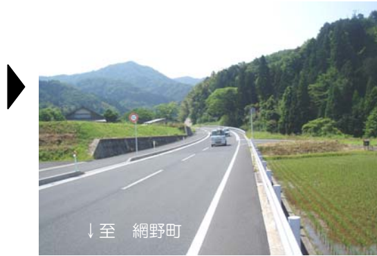
写真⑥ 【等楽寺工区】 開通後のバイパスの状況
