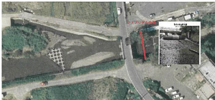
図 4.1.5 曾我谷川下流部のファブリダム
