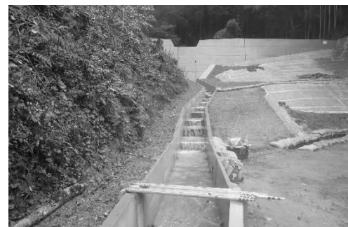
治山施設の流末水路の整備 (舞鶴市)
