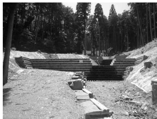
木製構造物の設置（福知山市）
