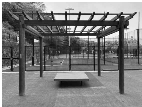
木製バーゴラの設置 公園 (京田辺市)
