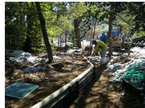
クロマツの根元柵設置
