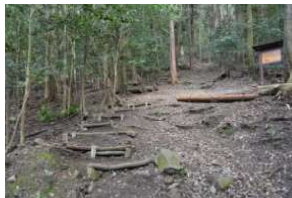
管理歩道補修
