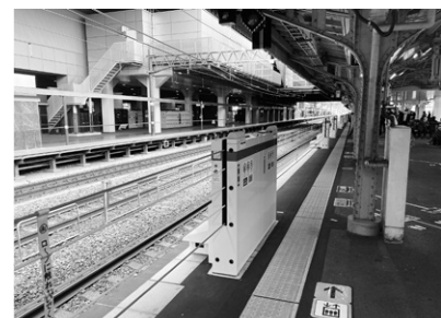
駅バリアフリー(京都駅ホームドア)
