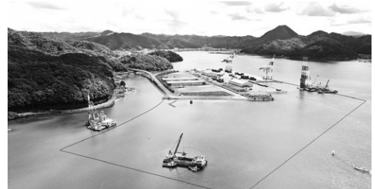
舞鶴国際ふ頭II期整備施工箇所
