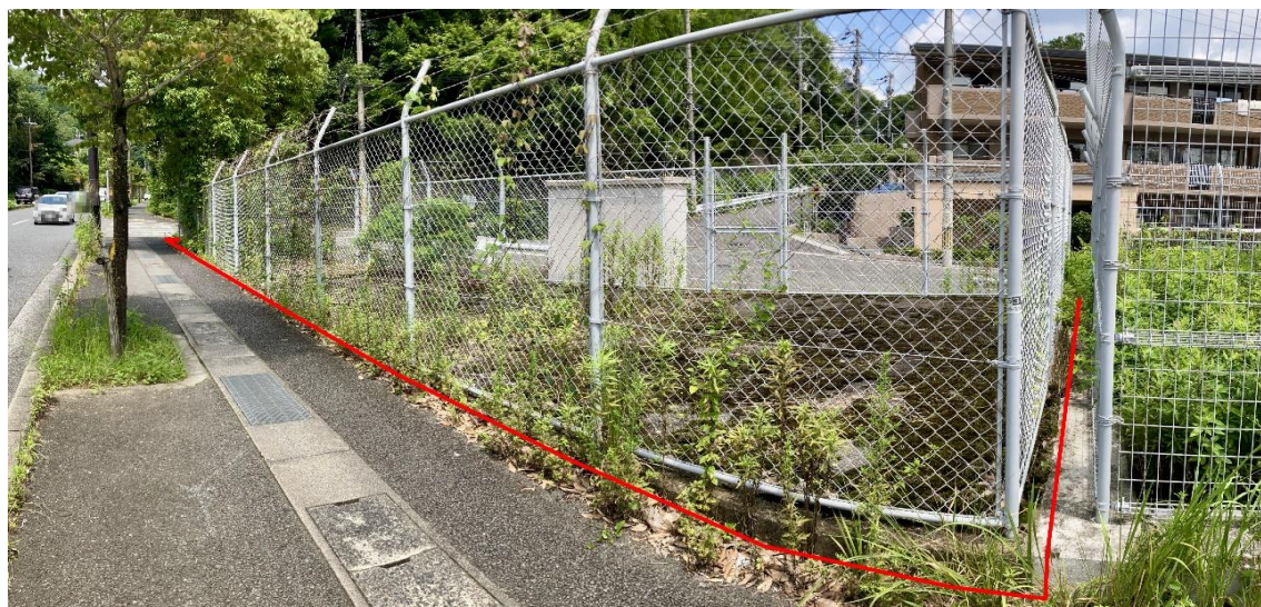
南東側より撮影
