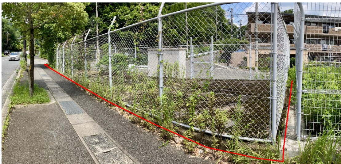
南東側より撮影
